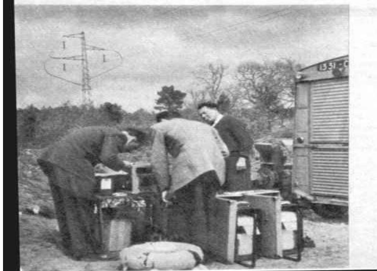
Au passage à niveau précédant la gare d'Ychoux, le laboratoire central de la signalisation avait installé un poste de chrono-mètre électronique relié à des contacts fixés en pleine voie. (Cl. La Vie du Rail C.B.)
